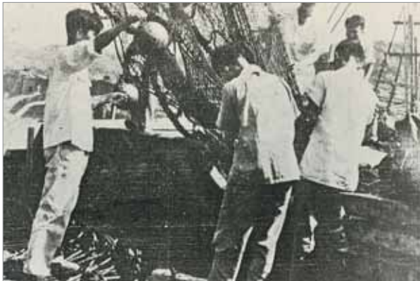
●補助漁船裝設無線電信機、新型漁具、航海儀器、設備、集魚燈、冷藏設備，提升效力及安全。
