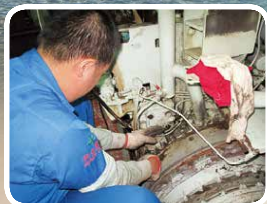
出港前進行檢修並備妥零件備品可減少意外事故發生。
