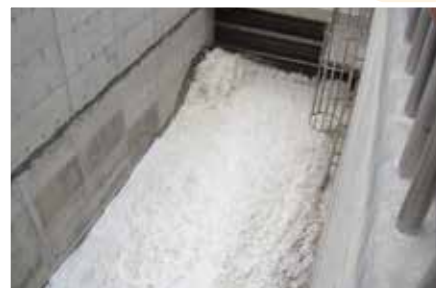
塭豐海水供水站第一次引水情形。 (攝影/李素貞)
