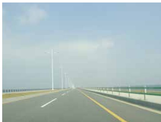
長達33.9 km 一望無際的海堤（Saemangeum seawall）。
