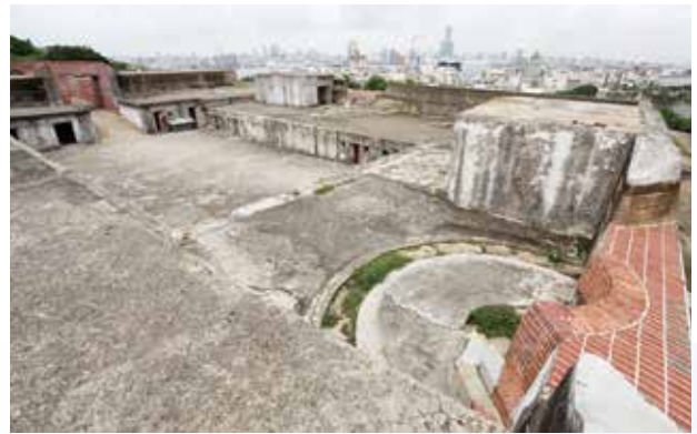
旗後砲台為清朝沈葆楨來臺時，聘英國工程師所設計建造的砲台古蹟。
