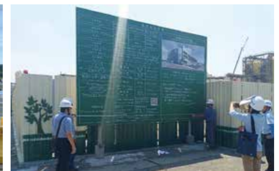
梧棲魚市場施工照片(告示牌)
