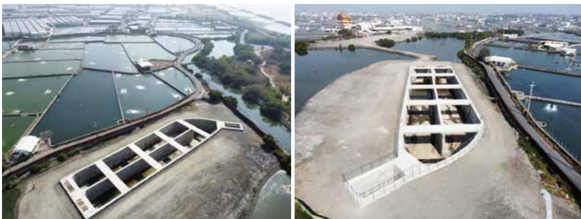
屏東縣下埔頭、大庄及東海養殖生產區生態景觀型海水供水系統工程竣工（第1期）
