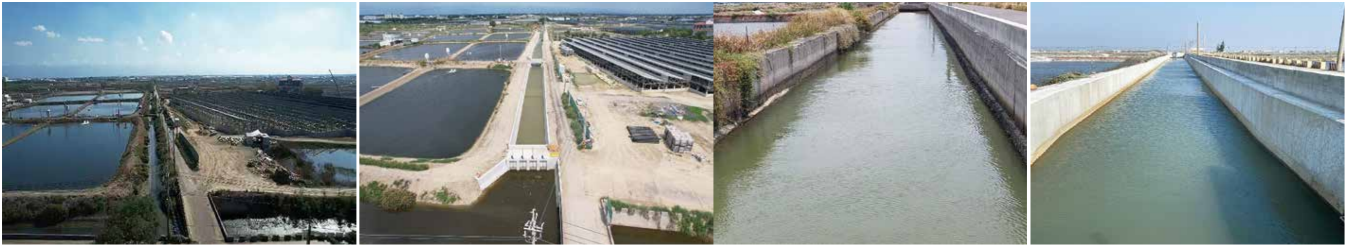
嘉義縣後鎮養殖區八中排施工前後照片
