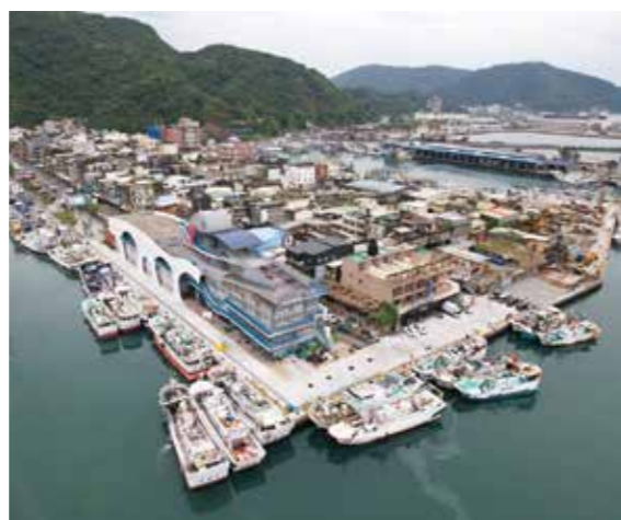
南方澳漁港第三泊區三角碼頭延伸段工程
