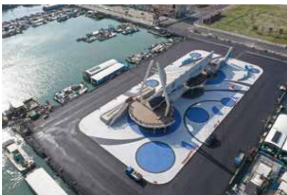
嘉義縣東石漁港水環境改善工程
