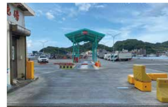
八斗子魚市場地磅改善工程
