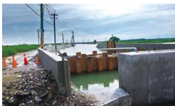
▲ 9月27日設置擋水鋼板（雲林縣下崙養殖區下崙南一中排改善工程）。
