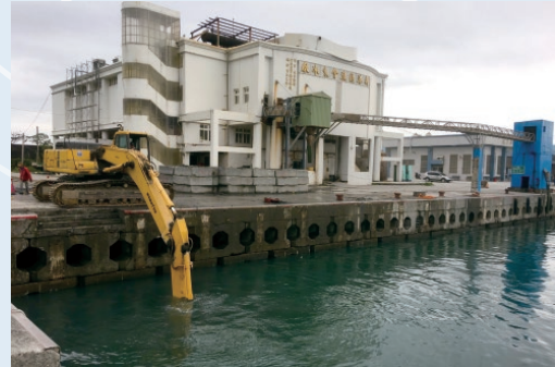
▲ 臺東縣新港漁港深水碼頭闢建工程－ 原碼頭水深不足，曾發生大型漁船挫底
