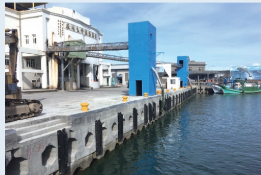
▲ 臺東縣新港漁港深水碼頭闢建工程－ 闢建後，水深達-4.0m，可供大型漁船停泊
