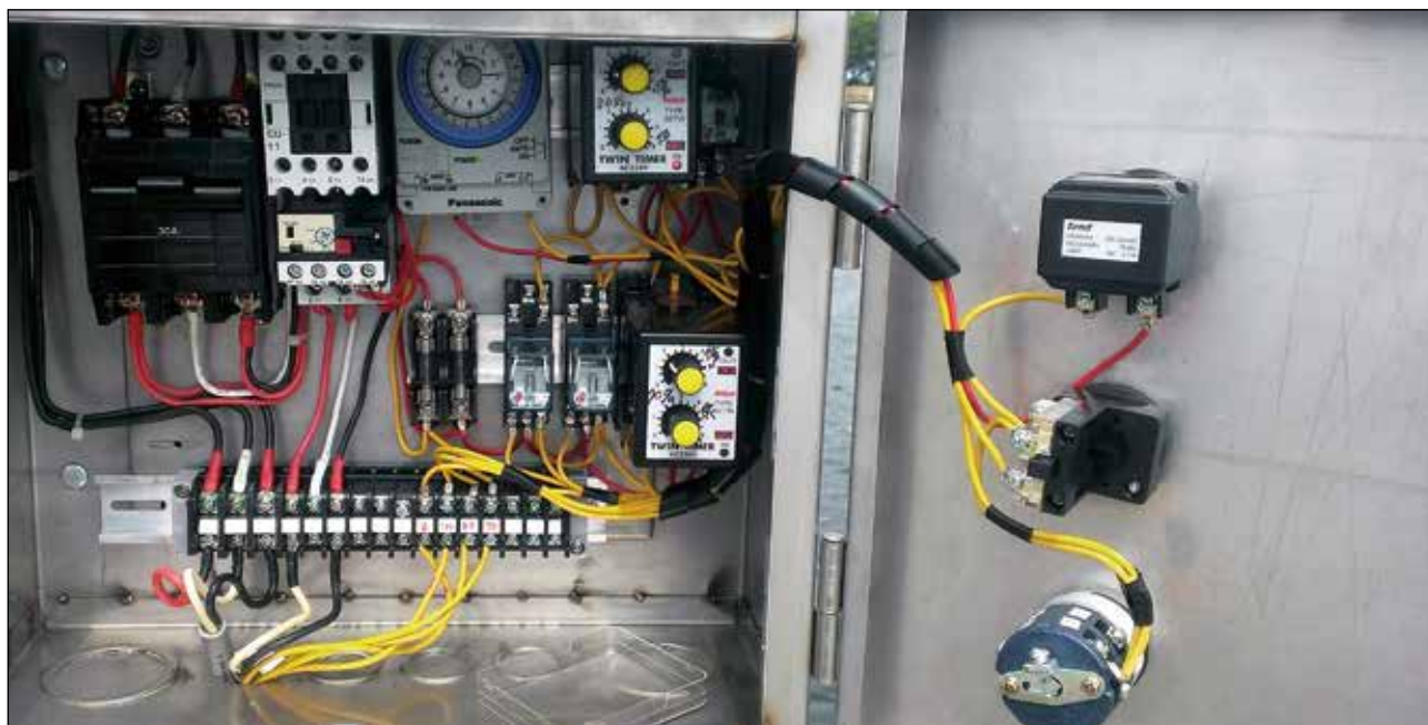
飼料供應控制箱之控制組件及控制線路。
