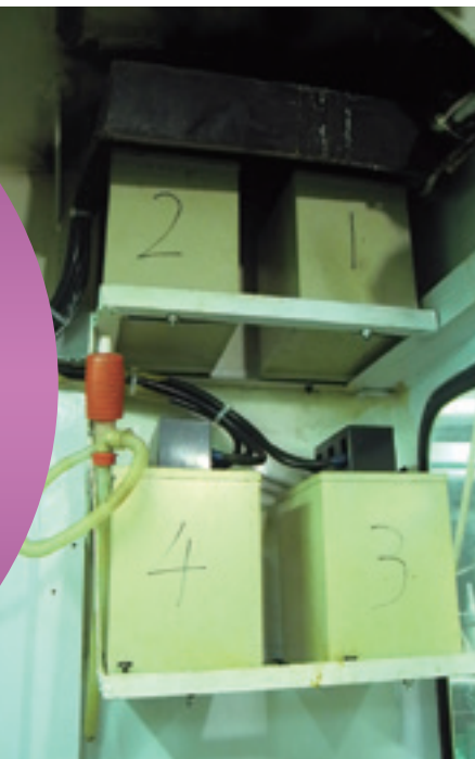
(圖四) 裝設於漁船控制室內之個別補償電容器。
