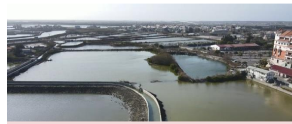
111年台南市南興七中排水治理工程
