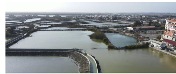
111年台南市南興七中排水治理工程
