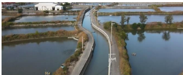
111年台南市北門雙春養殖區八中排水治理工程
