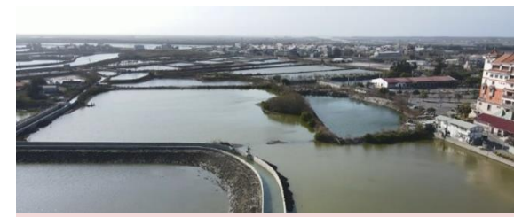
111年台南市南興七中排水治理工程
