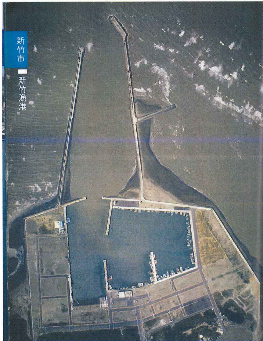
圖2 新竹漁港內泊地及外廓防波堤空照圖
