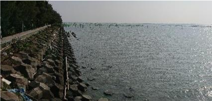
水岸及護坡照片
